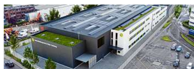
35 Millionen Euro investiert die S-Bahn in das neue Instandhaltungswerk
